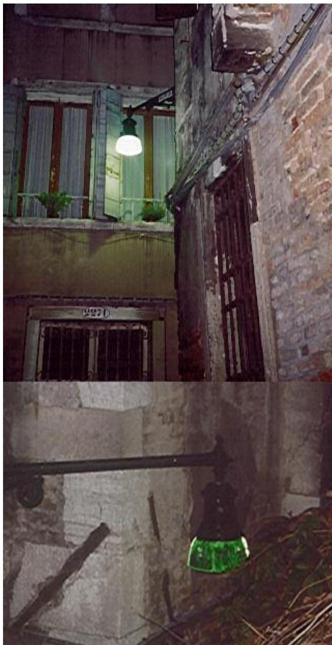
Figura 1. Sopra: Un apparecchio illumina direttamente dentro una casa. Sotto: Una schermatura “fatta in casa” ma funzionale è stata ottenuta dai tecnici del comune verniciando con una vernice opaca parte del vetro diffondente.
